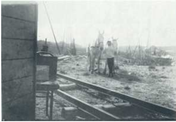
Afb. 77, Breitners schildersdoos op een bouwterrein aan de Cruquiusweg
