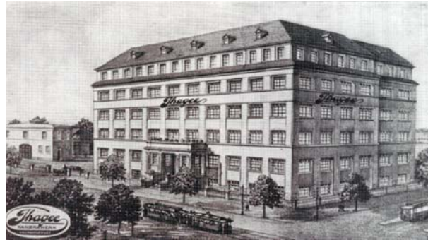
IHAGEE Kamerawerk Steenbergen & Co. Dresden Dresden A 19, Schandauer Straße 24 Endzustand des Erweiterungsbaus 1929
